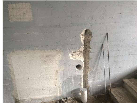
Prelevamento e analisi dei campioni di muratura per la caratterizzazione dei materiali
